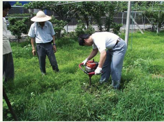
▲人力式引擎動力鑽孔，辛苦且危險
