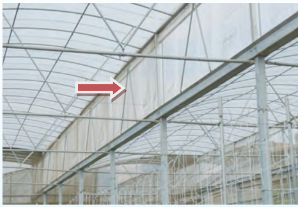
▲設施上方或側面通風處應有適當阻隔(箭頭處)
