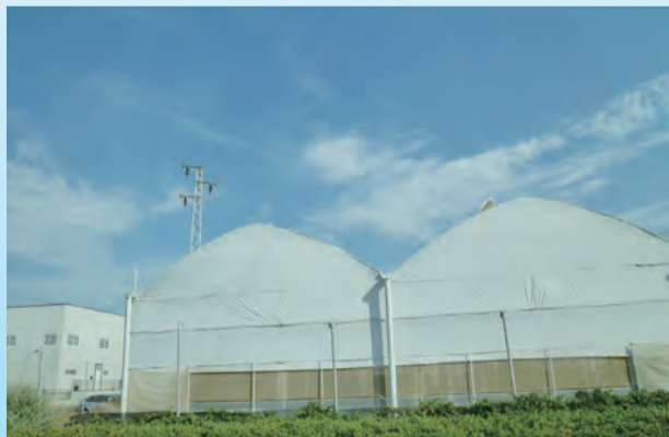
▲因地中海夏乾冬雨特性，夏季於溫室外層噴塗白色塗料，可減少太陽輻射，達遮陽、降溫但仍保有足夠光度
