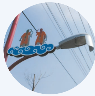
▲嘉義縣新港鄉道路路燈裝設燈罩(簡易鐵片)，讓光線集中路面，可降低路燈對大豆植株為害
