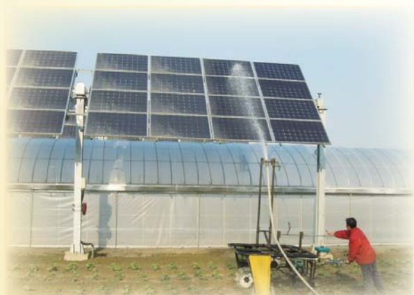
▲以水柱清洗太陽能面板可提升即時發電功率
