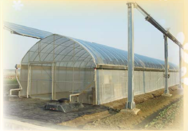
▲太陽能面板下設施頂之雨水收集系統使用現況
