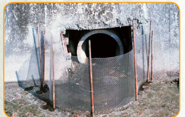
進水口裝置鐵絲網阻絕福壽螺侵入
