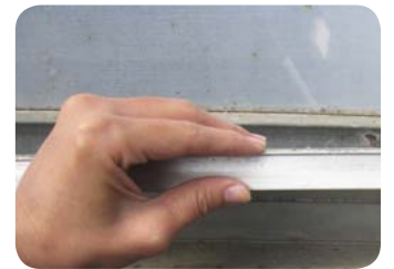
圖3. 水牆上方之鋁蓋板
