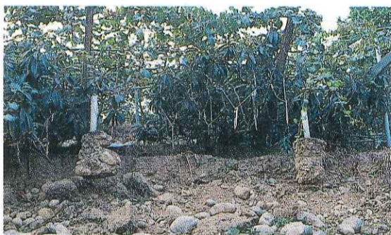
●葡萄棚下間作批把園之石砌護堤震散，棚架角柱基座露出（張林仁攝）
