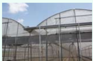
▲連棟溫室之雨水收集情形
