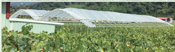
▲遮雨設施主要目的為防雨，採用捲揚式屋頂可依生產期間天候狀況進行調整，更利於葡萄生育（上為天候良好時屋頂打開狀態，下為雨天關閉情形）
