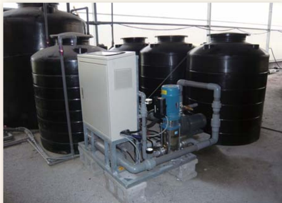
圖一、自動肥灌系統主機包含控制器及注肥器，另外還有過濾器、養液桶、幫浦、管路系統、滴頭等
